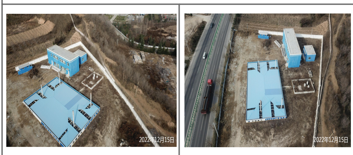
4#取土场现状航拍影像
