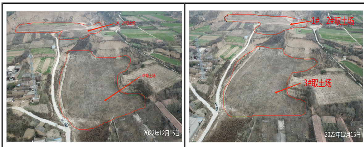
1#、2#、3#取土场现状航拍影像
