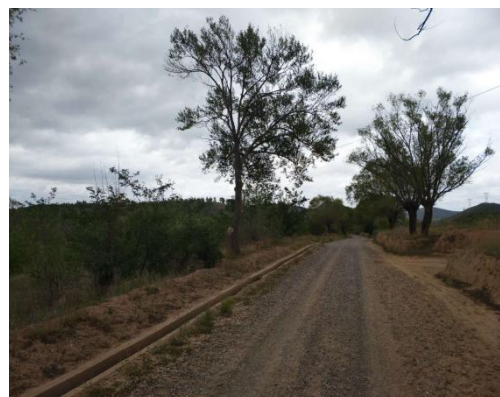
检修道路及排水沟
