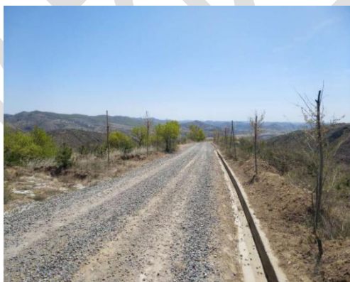
检修道路及排水沟
