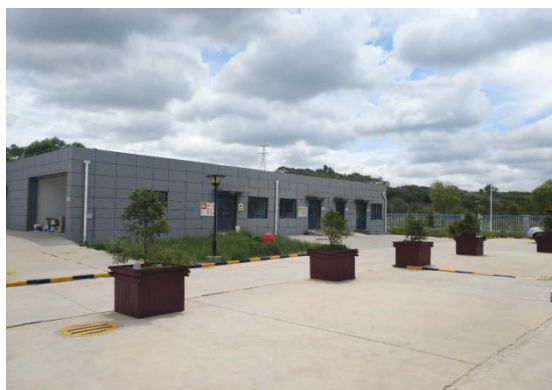
升压站内硬化绿化
