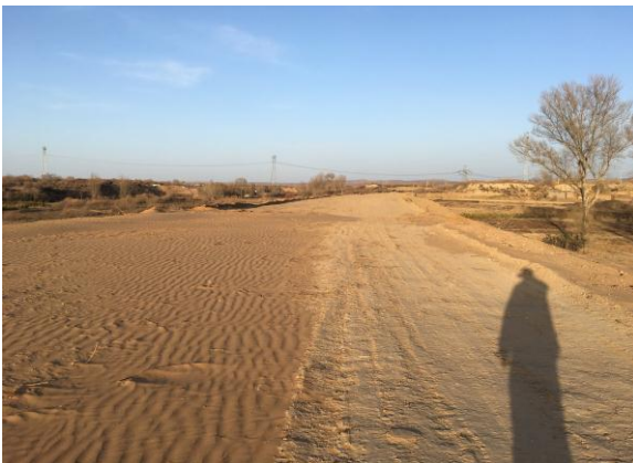
图 1-5 跨越榆靖公路（在建）
