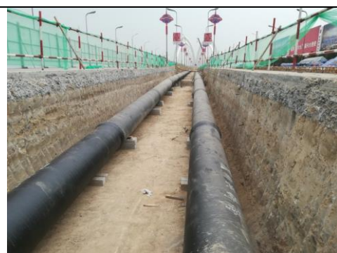
给水管道埋地段施工
