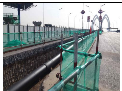
给水管道基坑围护施工
