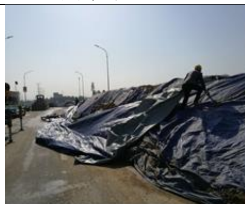
施工期临时堆土覆盖
