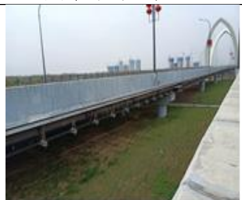
给水管道悬吊段下部植被现状
