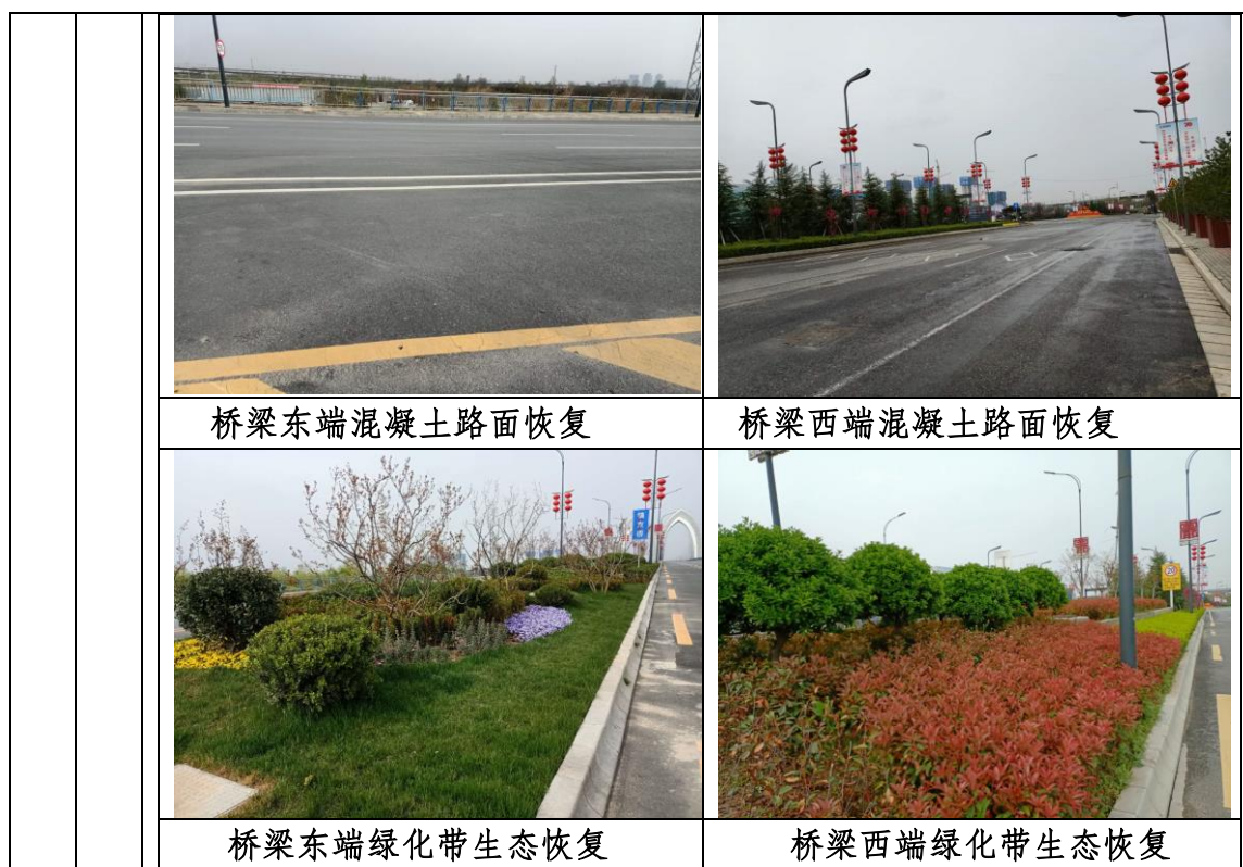
图 7-1 临时占地及生态恢复情况
