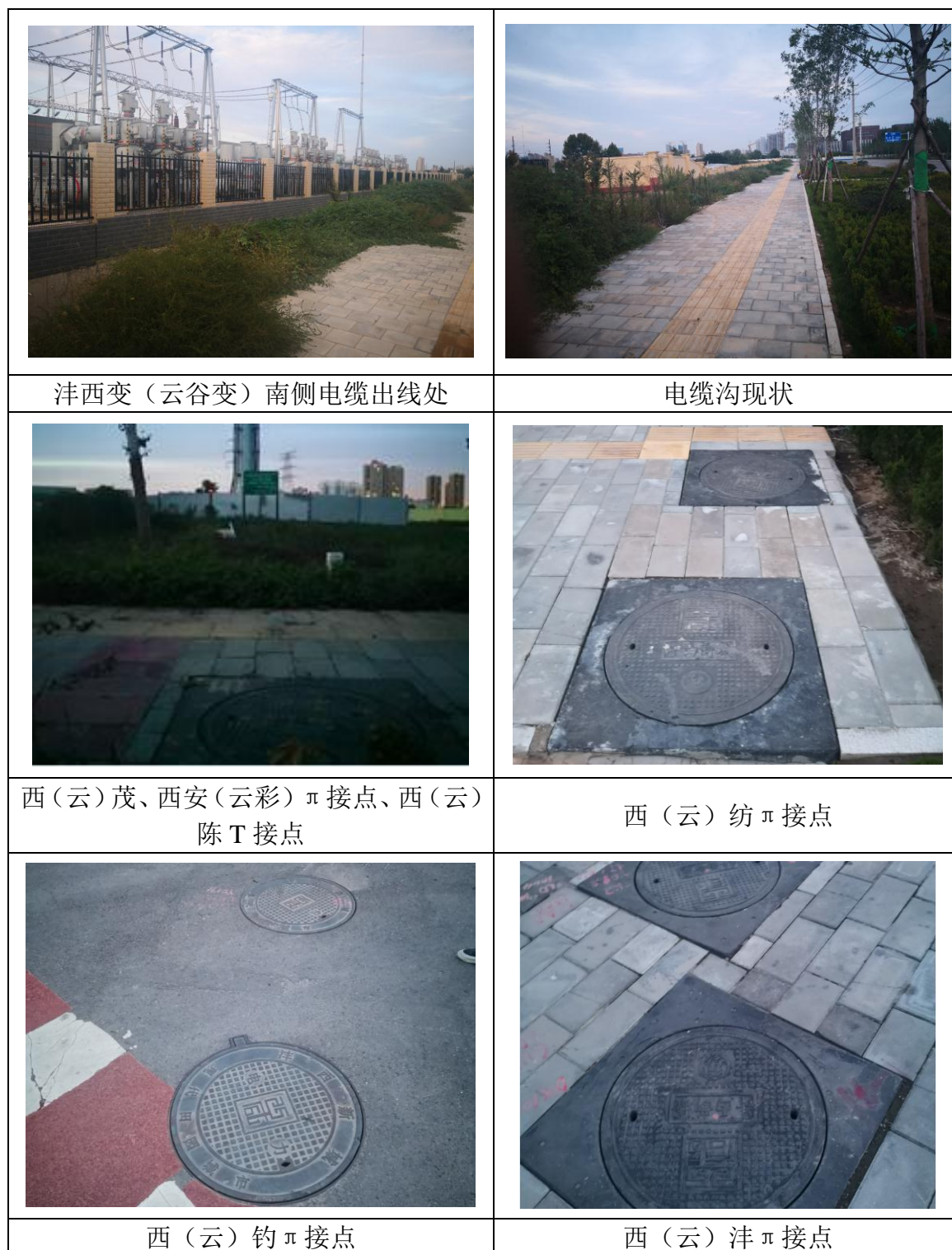
图 4-7 本工程电缆线路现状
