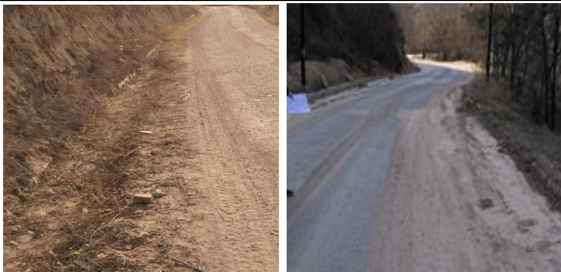
道路一侧管线埋设段回填平整及生态恢复
