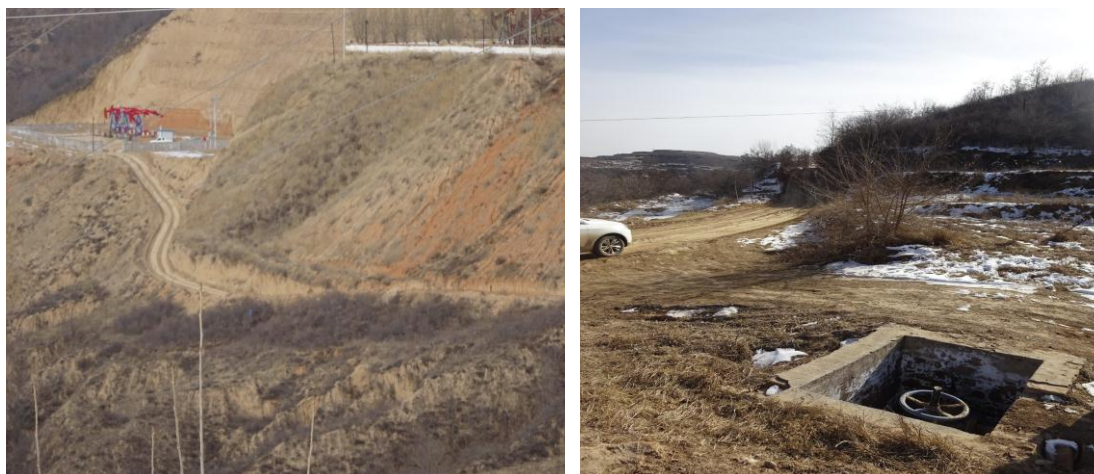
施工便道及侧旁管线生态恢复
