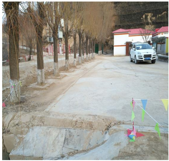
贺一转站外路面恢复
