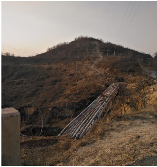
管线跨沟及土坡埋设段生态恢复
