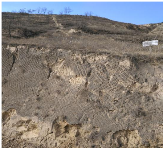
管线土坡埋设段回填平整及生态恢复
