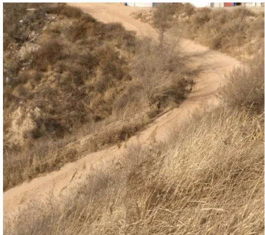
管线土坡埋设段回填平整及生态恢复
