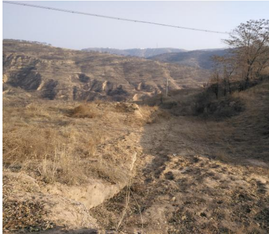
管线土坡埋设段回填平整及生态恢复
