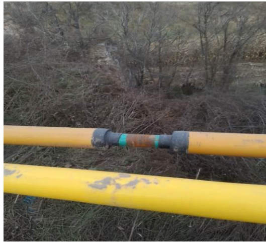
管线焊接、防腐
